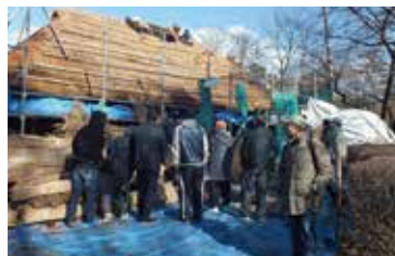
茅葺き屋根葺き替え見学会 (福島市「あづま運動公園民家園」)
